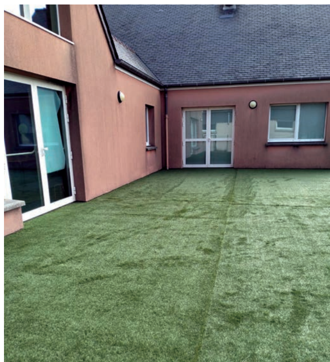
Le sol de l'extérieur de la garderie a été changé
